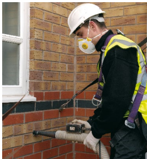
3 Proceso de insuflado.
