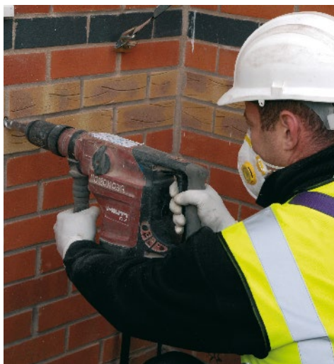
2 Prueba de densidad y equipos. Actuaciones previas si es necesario.
