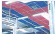
Panel rígido autoportante de grandes dimensiones, en Lana de Roca con fuerte absorción acústica, revestido de un velo decorativo sobre la cara vista y reforzado por un velo de vidrio neutro sobre la cara oculta. Su proceso de fabricación le garantiza un perfecto comportamiento mecánico en el tiempo.
