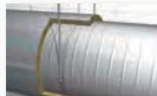
En el caso de protección frente al fuego de conductos circulares, el sistema consiste en un revestimiento de mantas reforzadas con una malla de acero galvanizado.
