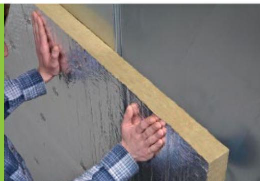
Para facilitar el trabajo de montaje del aislamiento, los productos U Protect se presentan en forma de paneles, como las soluciones convencionales presentes en el mercado sino también en formato mantas para los conductos circulares. Estas mantas están reforzadas con una malla de acero galvanizado para simplificar el sellado del aislamiento.
