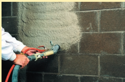
2. Proyección del mortero
