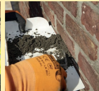
4. Sellado de agujeros y acabados.
