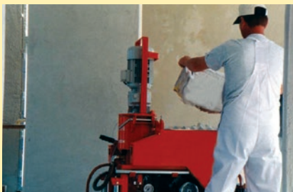
1. Mezcla del mortero
