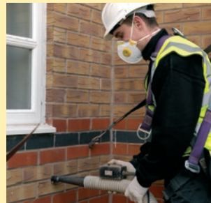
3. Proceso de insuflado.
