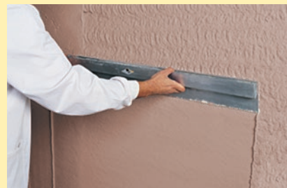
3. Regularización de la superficie
