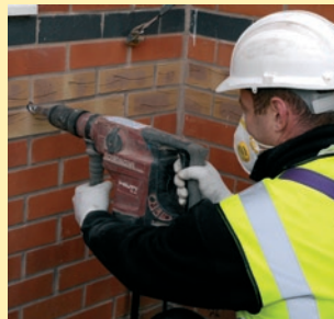
2. Prueba de densidad y equipos. Actuaciones previas si es necesario.
