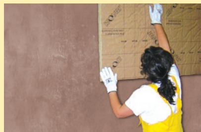
4. Fijación del aislamiento
