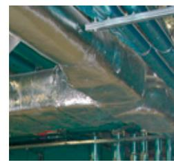
La solución ISOVER para el aislamiento por el exterior de conductos metálicos. CLIMCOVER
