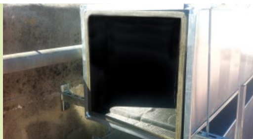
Al ras de la junta del conducto de chapa en el caso de la hembra.
