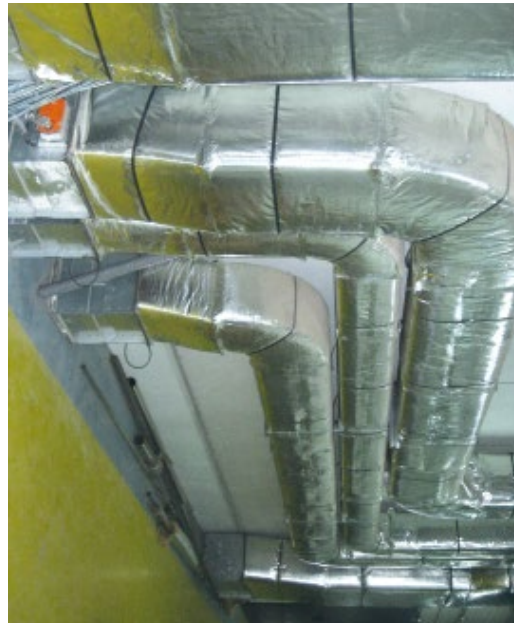
Aislamiento fijado con flejes
