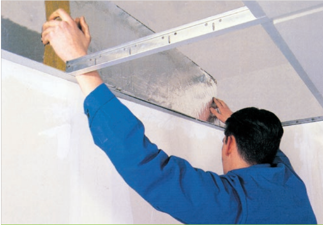
Barrera acústica vertical de fácil corte para adaptarse a las distintas alturas de los plenum
