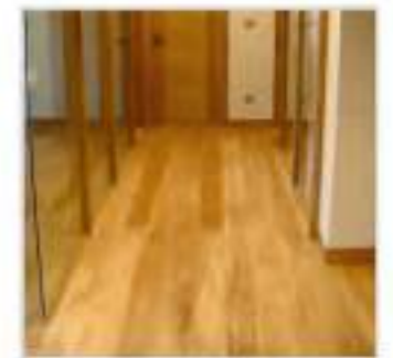
Tarima interior y exterior
