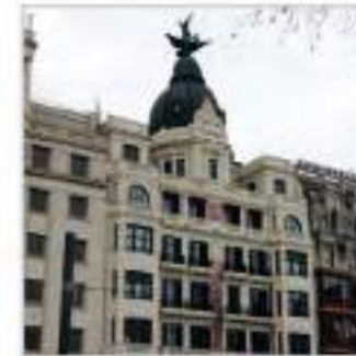
Obra nueva y rehabilitaciones
