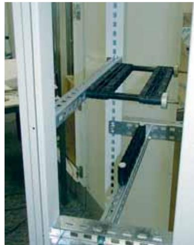
En la parte superior de la foto, detalle del soporte del embarrado UC824 (para embarrado vertical) y en la parte inferior detalle del soporte para extremo de barras en embarrado vertical (UC825).
