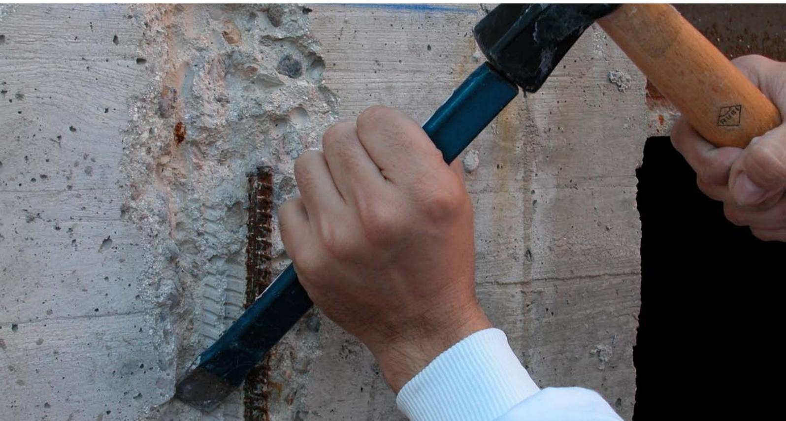
Figura 2. Preparación de la superficie a reparar
