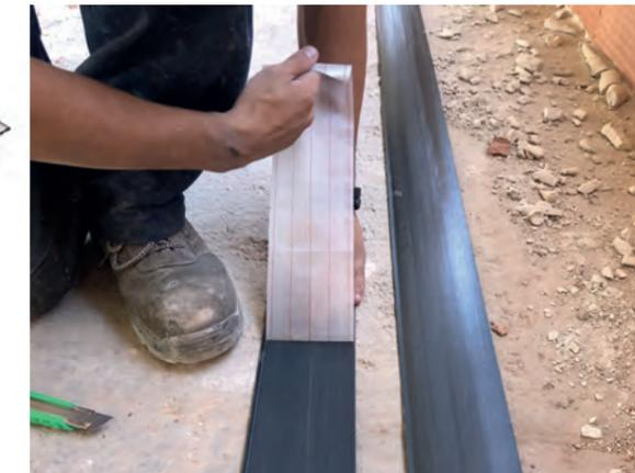
Retirada de la banda "peel-ply"
