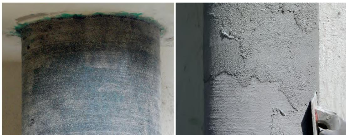
Espolvorear árido de sílice sobre la capa de Adhesivo Carbotec Impregnante para generar rugosidad.
