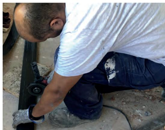
Corte de Lámina Carbotec con Rotaflex
