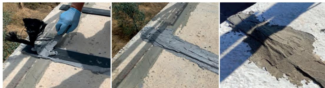
Colocar el Conector Carbotec en el extremo del laminado, previa realización y limpieza de la perforación.\*
