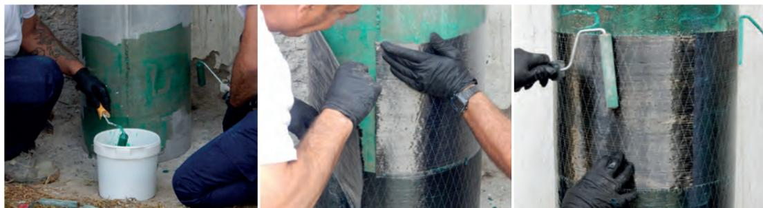
Aplicar el Adhesivo Carbotec Impregnante sobre el soporte con un rodillo de pelo corto.
