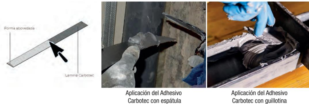
2. Aplicar el adhesivo de manera que no quede plano y uniforme, sino con un espesor mayor en el centro y disminuyendo progresivamente hasta los extremos. El espesor final de la capa de adhesivo es de 1,5 mm a 2 mm. En la ficha técnica de la Lámina Carbotec se indica el consumo estimado de adhesivo para cada anchura de laminado.
