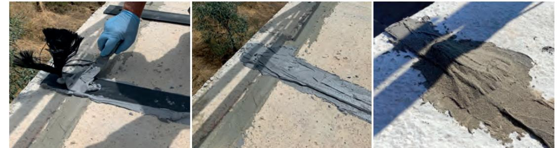
Colocar el Cordón Carbotec en el extremo del laminado, previa realización y limpieza de la perforación.\*
