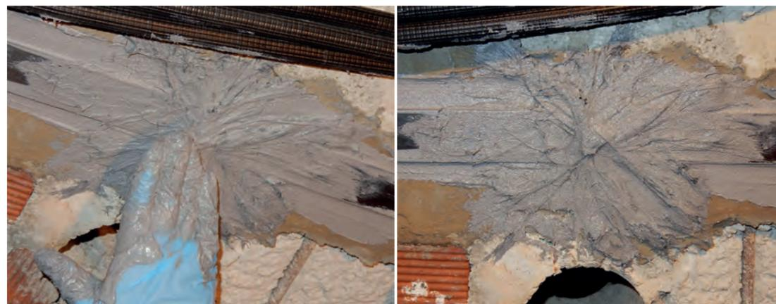
Extender y pegar las fibras de la zona flexible del Cordón Carbotec
