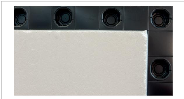
Después de haber colocado en las paredes de las habitaciones la banda perimetral K369A (con función aislante para eliminar el puente térmico en el borde y permitir las dilataciones mínimas del pavimento), se procede extendiendo y encastrando los paneles de manera que las filas siguientes se queden escalonadas.
