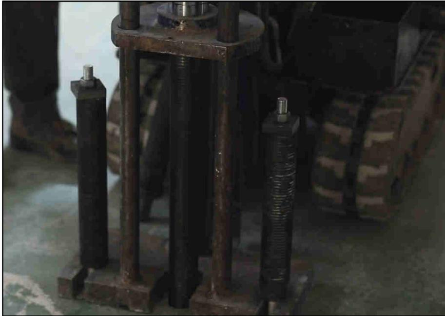
Imagen n.º 2: Aspecto de la maquinaria de hincado en el proceso de hincado de un micropilote MP/60.
