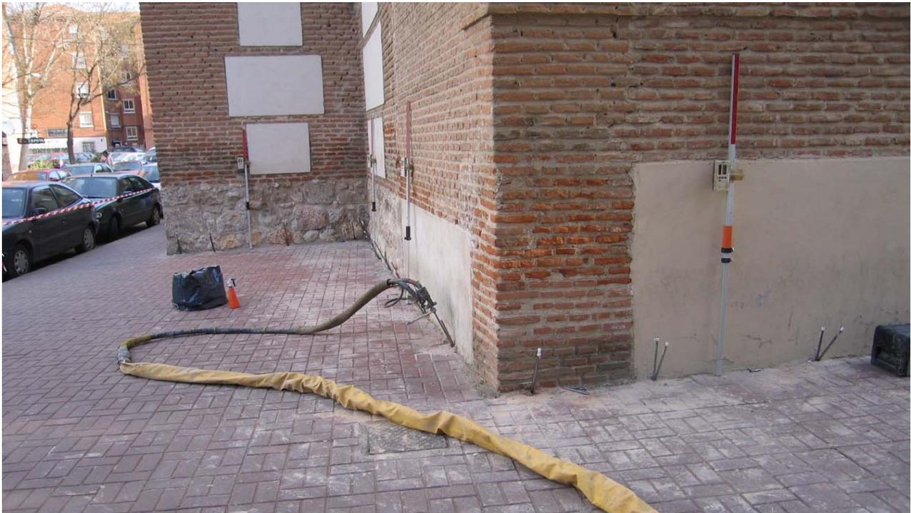
*Ejecución de las inyecciones de resina y control de la estructura mediante sensores láser dispuestos en los paramentos verticales.*
