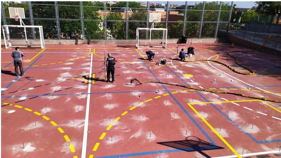
*Ejecución de las inyecciones de resina y control de la estructura mediante sensores láser dispuestos alrededor del punto de inyección.*
