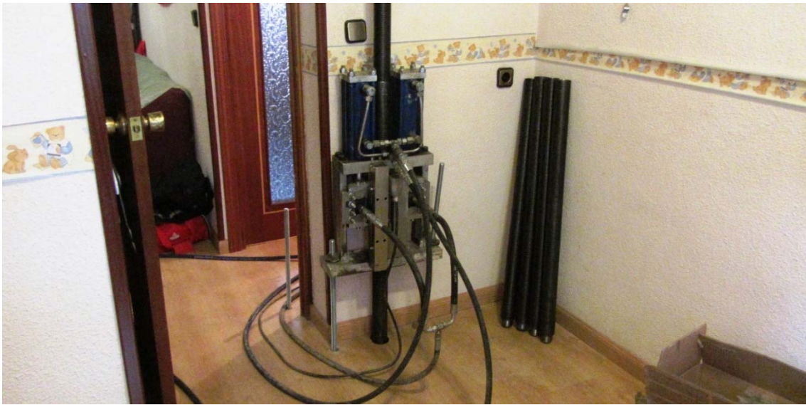
Aspecto de la maquinaria de hincia en el proceso de inserción de un micropilote MP/60.
