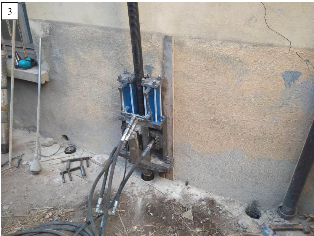
3. Colocación del pistón hidráulico.
