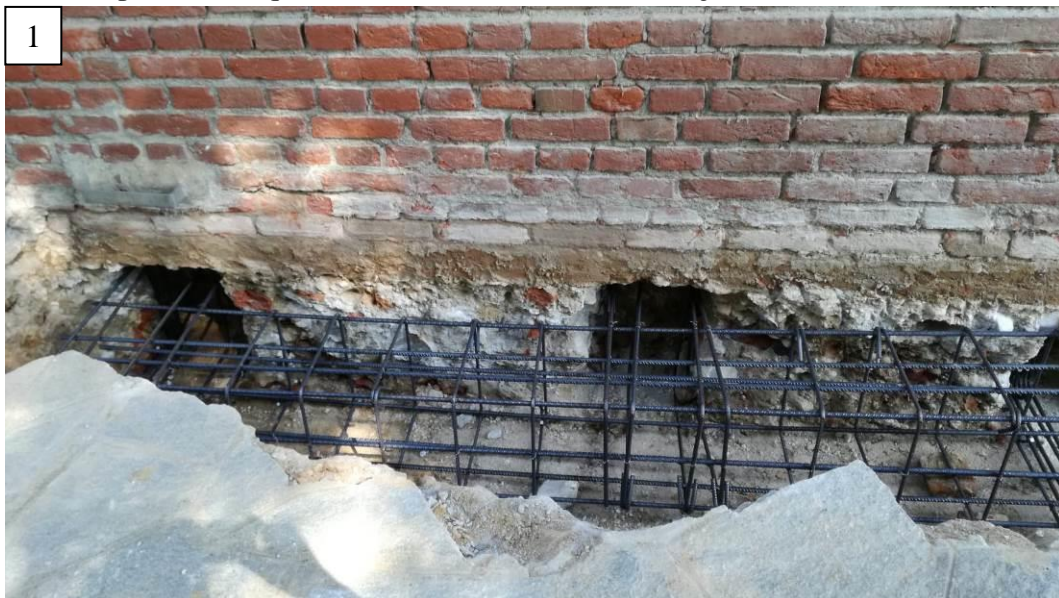
1. Realización de la excavación y colocación del armado.
