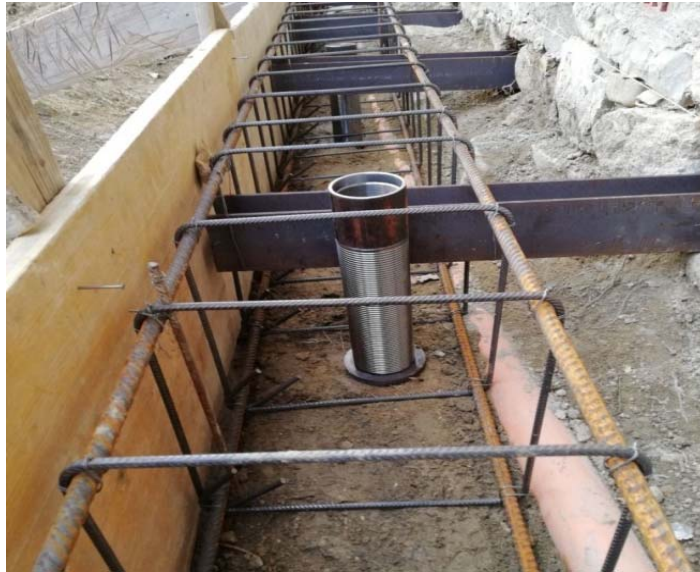
Inserción con camisas metálicas.
