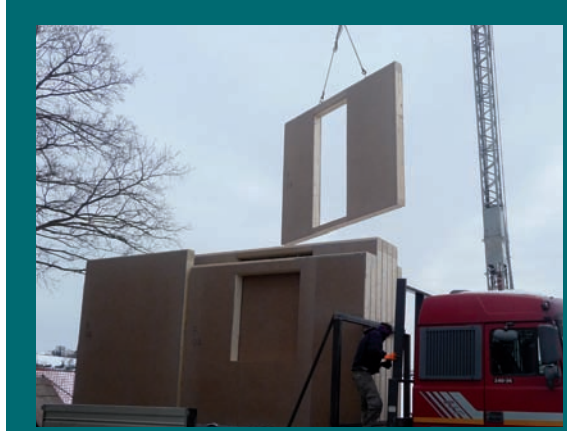
Paredes interiores e lajes construídos com Superpan Tech P5.
