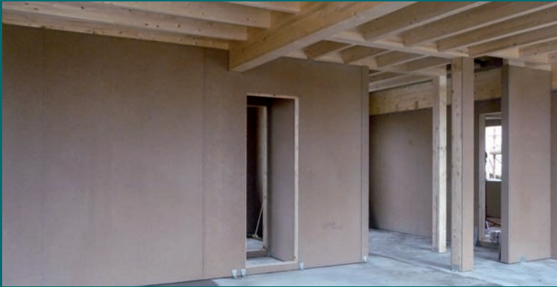
Paredes interiores e lajes construídos com Superpan Tech P5.
