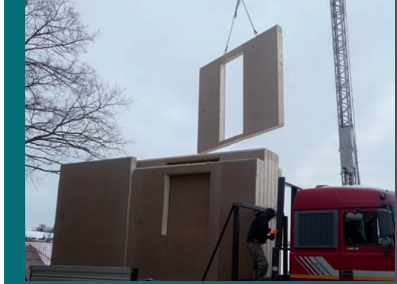
Tabiques interiores y forjados construidos con Superpan Tech P5.
