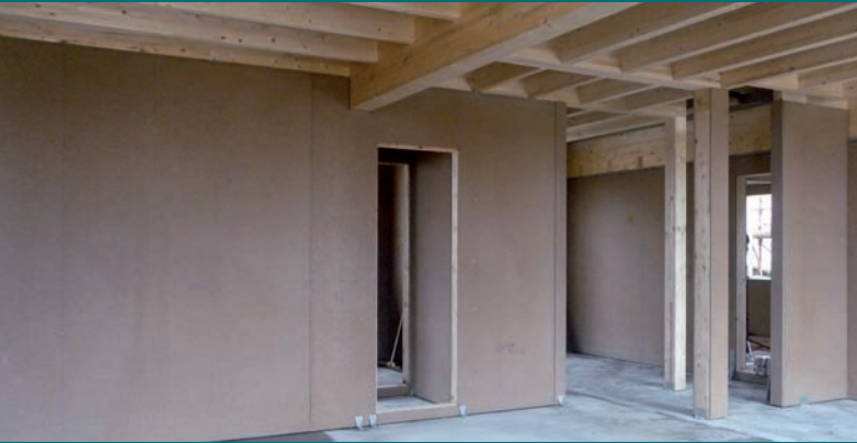
Tabiques interiores y forjados construidos con Superpan Tech P5.
