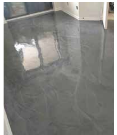
BASE DE MICROCEMENTO SIN MALLAS
