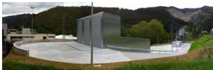
Estación de Transferencia Reciclados (3kg) Debarrena
