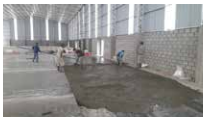
Nave industrial Ezeiza (2kg) Buenos Aires
