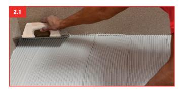
2. Aplicar un mortero adhesivo adecuado al soporte. Usar un cemento cola con clasificación mínima de C2 S1 según EN 12004 o ISO 13007 o bien que cumpla con las normas ANSI A118.4, ANSI A118.11 o ANSI A118.15
