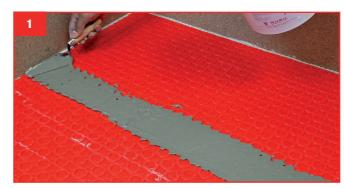
**1.** Aplicar cemento impermeable polimérico **EASEAL** centrado en una franja de 15 a 20 cm (6" a 8") de ancho.
