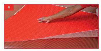
**4.** Instalar a continuación del mismo modo las siguientes piezas de G-Flex. Para asegurar una superficie plana, no sobreponer los bordes o extremos de una lámina sobre otra. Extender G-Flex juntando borde con borde con las piezas adyacentes sin dejar vacíos de más de 3 mm entre láminas.
