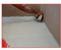
Aplicar un mortero adhesivo adecuado al tipo de revestimiento. Usar un cemento cola con clasificación mínima de C2 según EN 12004 o ISO 13007 o bien que cumpla con las normas ANSI A118.4, ANSI A118.11 o ANSI A118.15
