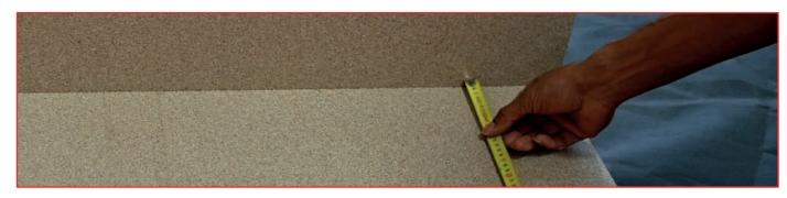
1. Cortar G-Flex a la medida y forma necesaria, considerando dejar un espacio de 6 mm (1/4 de pulgada) entre la lámina y los muros perimetrales, columnas, elementos arquitectónicos, juntas estructurales, desagües, etc. La lámina G-Flex se corta fácilmente con tijeras o con cúter.
