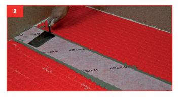
**2.** Colocar la banda W-S BANDA 14 centrada sobre la línea de unión y presionar con fuerza con la parte lisa de la llana para lograr total adherencia.
