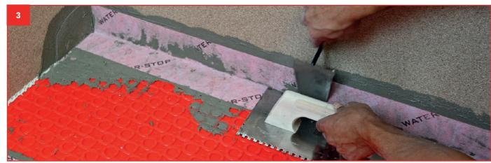
3. Colocar la W-S BANDA sobre la capa de pegado y ajustar primero en las paredes y luego solapando al menos 6 cm (2-1/2") sobre G-Flex. Presionar con la parte lisa de la llana o con espátula para eliminar aire y exceso de material.
