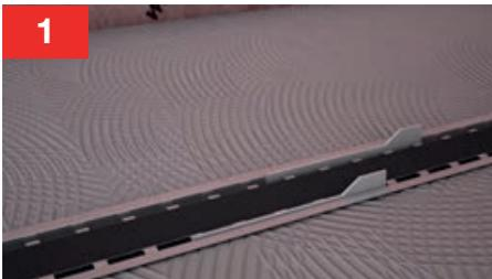
2. Insertar los distanciadores a cada lado en las ranuras de desagüe para asegurar la anchura adecuada de las mismas y dar la referencia para iniciar la colocación del pavimento.
