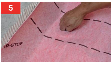
6. Pegar la lámina sobre toda la superficie limpia y seca, tanto en el suelo como en los remotes, con cemento cola tipo C2. Colocar la cazoleta.
