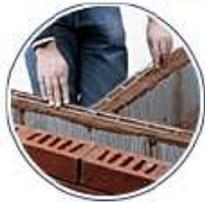
Diseñado como refuerzo estructural de obras de fábrica y control de fisuración.
