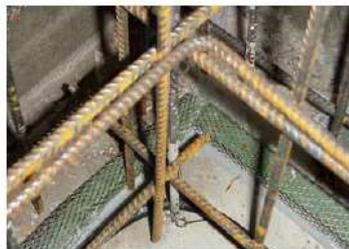
5. Por último, fijar la manta al sustrato mediante clavos para evitar que se desplace durante los trabajos de ferrallado u hormigonado.
