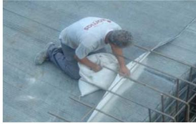
4. Pegar la junta de bentonita de sodio natural Bentostrip 20x10 mm o 25x19 mm en las diferentes juntas de hormigonado entre distintos elementos constructivos (losa – muro, muro – muro, losa - losa)
