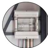
Cuadro eléctrico independiente para alimentación de luminarias, enchufe ventilación, ventilador y termostato.
