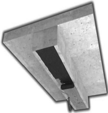
Figura 7. Colocación de tejido DRIZORO® WRAP en vigas
