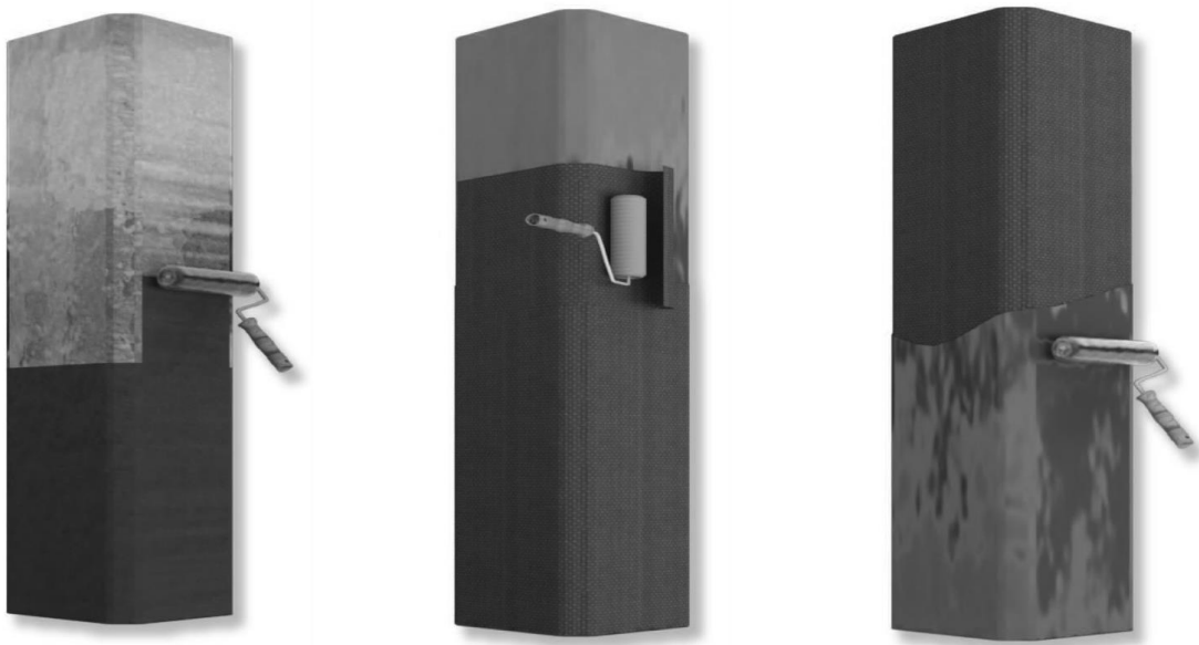
Figura 10. Colocación del sistema DRIZORO® WRAP para refuerzo por confinamiento en pilares.
