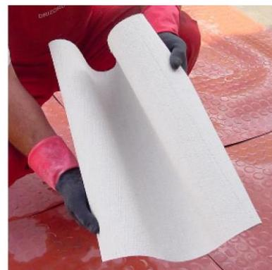
20 cm. Fijada la malla, se aplicará una capa final de **MAXSEAL® FLEX**.
