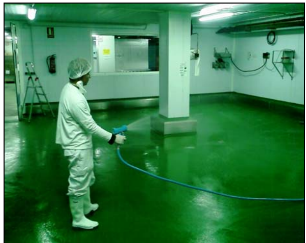
Puesta en servicio del pavimento
