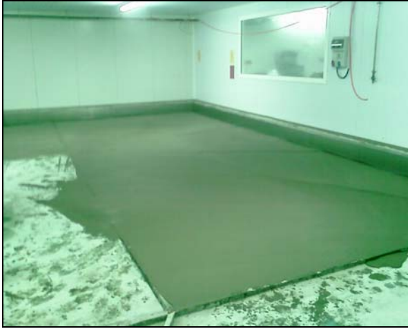
Regularización con MAXFLOOR® CEM
