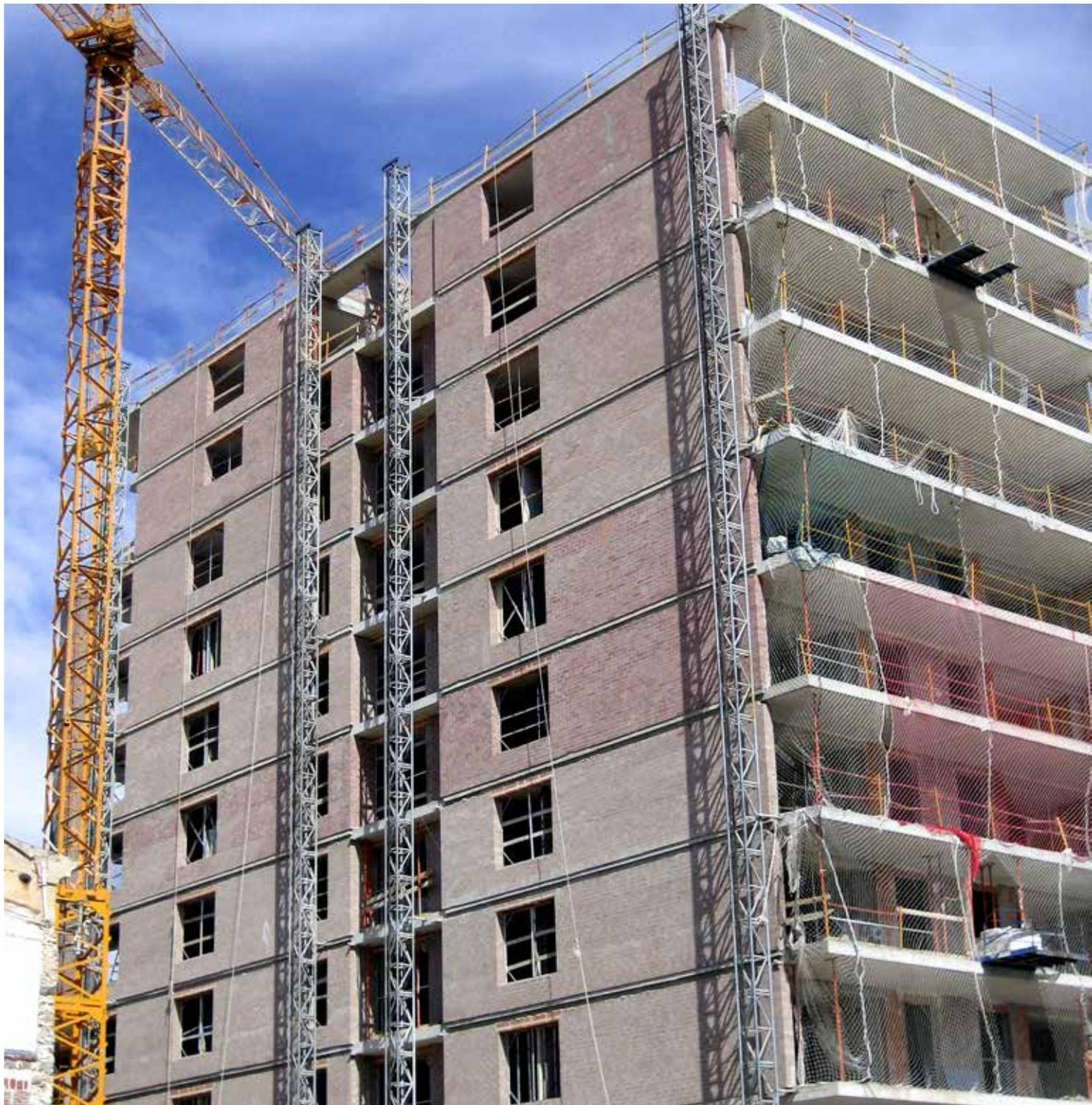
Cerramiento de fachada con Geroblok perforado 50 dBA.
