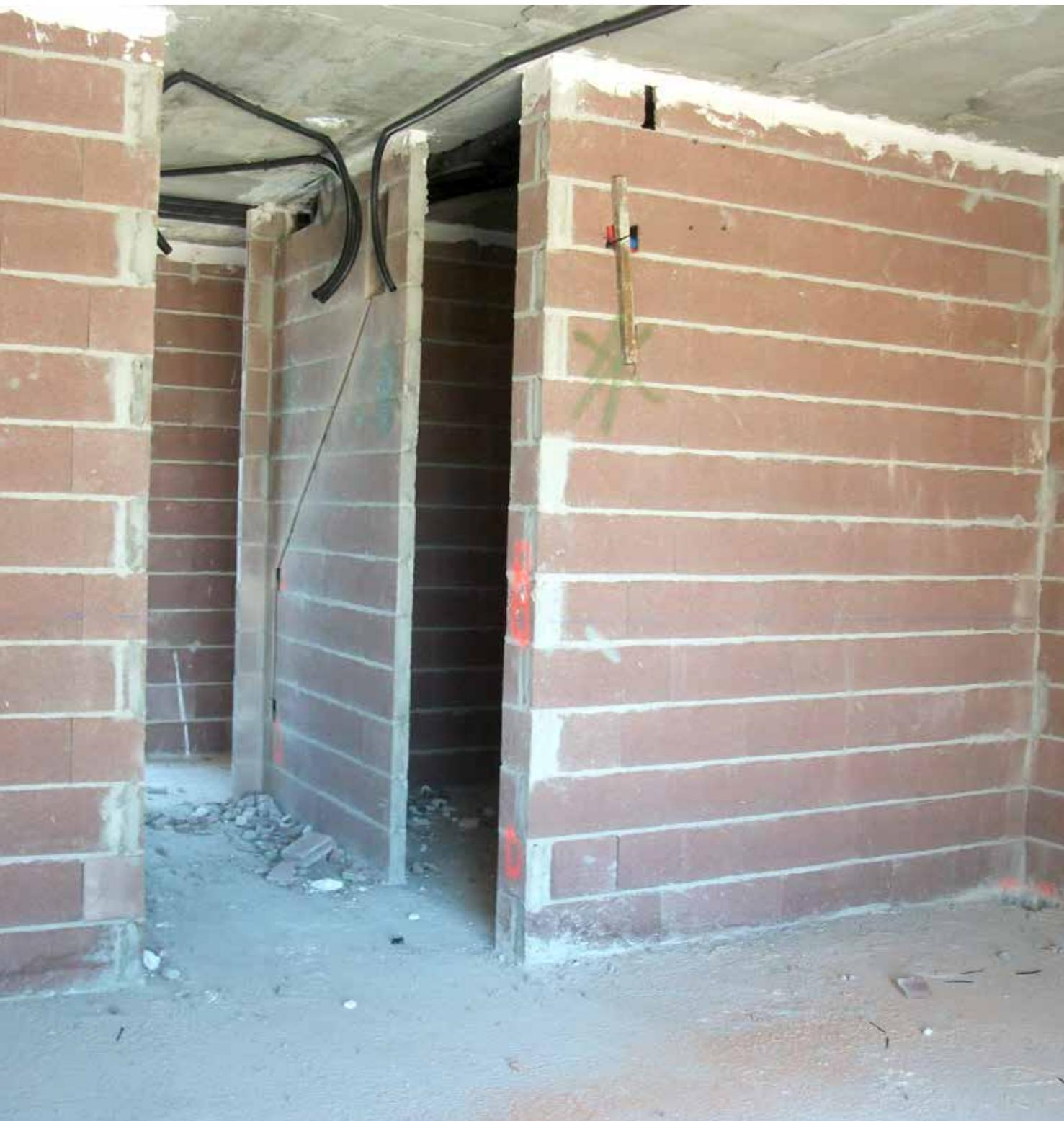
Distribución interior de una vivienda con Geroblok. Tabique 38 dBA. No requiere utilización de bandas perimetrales.
