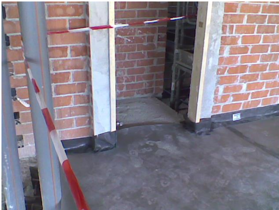
Fotografía 2: Protección de precercos y aspecto general de solape vertical.
