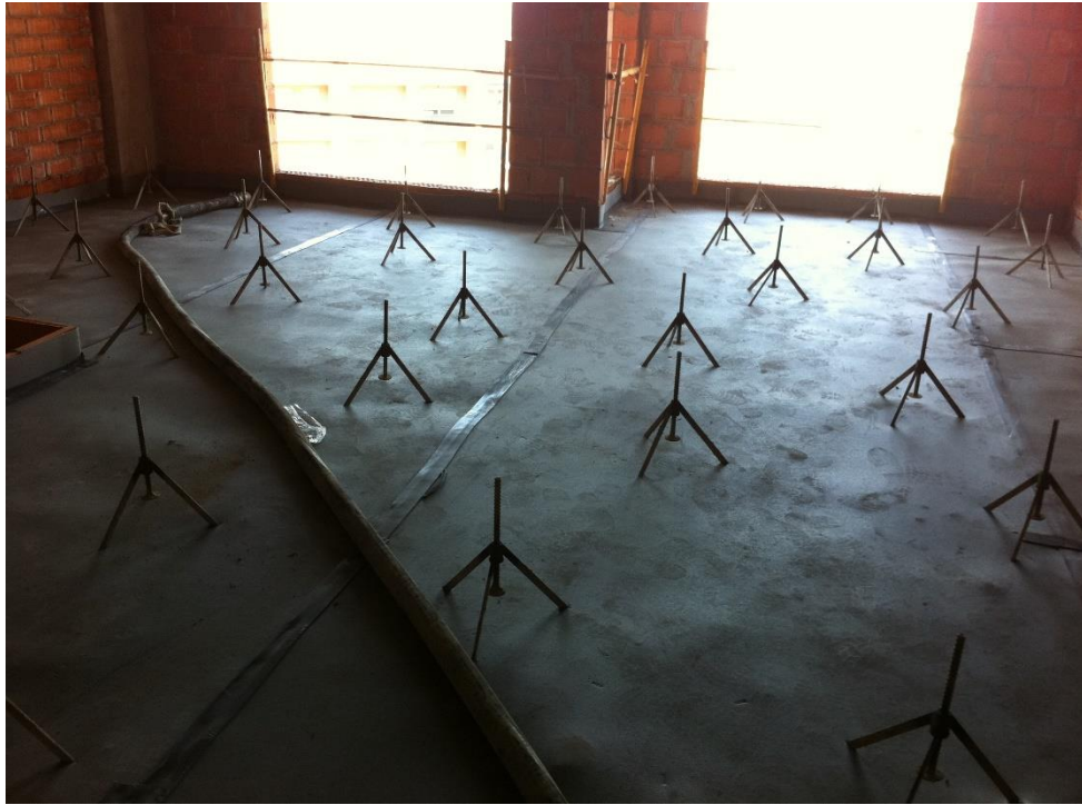
Fotografía 1: Colocación general. Listo para verter mortero.
