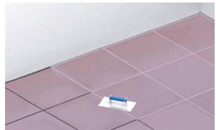
6. Verter ARJUNT® Universal mezclado con resina de látex (140 g/kg de ARJUNT®) para tapar las juntas.
