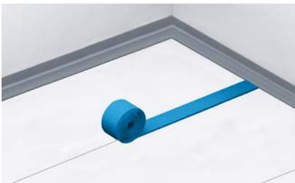
4. Conviene sellar con cinta adhesiva para evitar el paso de humedad y con cinta de solape en los perímetros.
