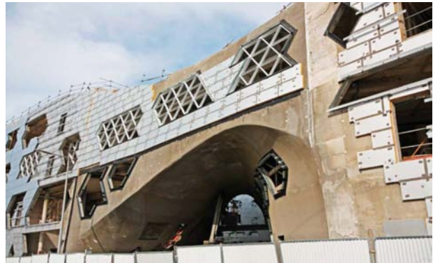
Adaptación de las planchas rígidas de PIR sobre cualquier geometría del edificio.
