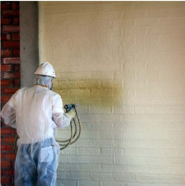
Proceso de proyección de poliuretano
