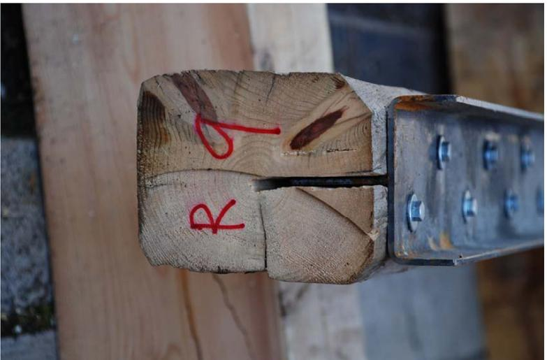
RECUPERACIÓN DE LA CAPACIDAD MECÁNICA EN PIEZAS DE MADERA SOLICITADAS A FLEXIÓN EN ESTRUCTURAS TRADICIONALES OPERANDO POR LA CARA SUPERIOR MEDIANTE REFUERZOS Y PRÓTESIS METÁLICAS
