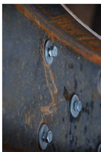
RECUPERACIÓN DE LA CAPACIDAD MECÁNICA EN PIEZAS DE MADERA SOLICITADAS A FLEXIÓN EN ESTRUCTURAS TRADICIONALES OPERANDO POR LA CARA SUPERIOR MEDIANTE REFUERZOS Y PROTÉSIS METÁLICAS
