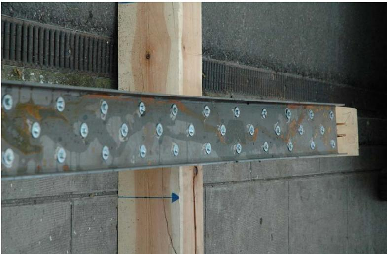
RECUPERACIÓN DE LA CAPACIDAD MECÁNICA EN PIEZAS DE MADERA SOLICITADAS A FLEXIÓN EN ESTRUCTURAS TRADICIONALES REFORZANDO POR LA CARA SUPERIOR MEDIANTE REFUERZOS Y PRÓTESIS METÁLICAS
