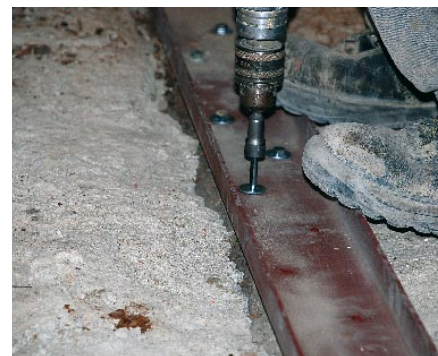
Atornillado de tirafondos de forma mecánica.
