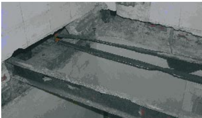
Forjado de viguetas IPN de acero laminado, con 10 años de antigüedad, en una vivienda del casco urbano de Madrid.
