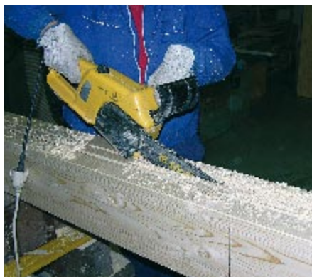
Acanaladuras en la madera practicada con sierra motorizada.
