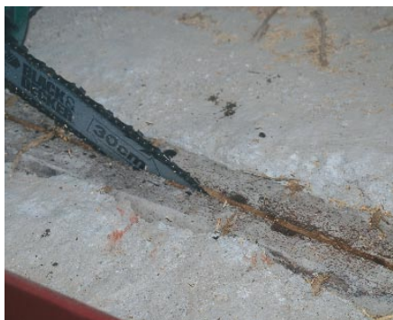
Corte de la madera con sierra motorizada.
