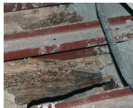
Vigueta con ataque en punta reforzada con prótesis.
