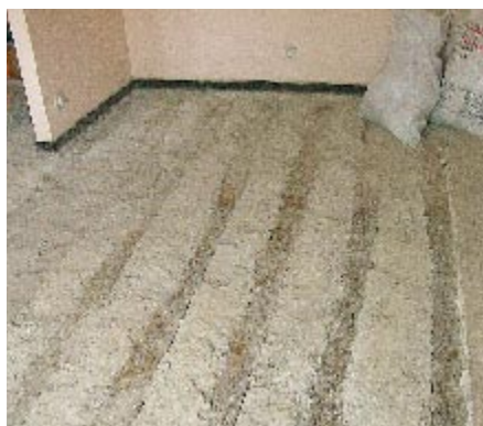
Forjado de madera tras retirada de solado.
