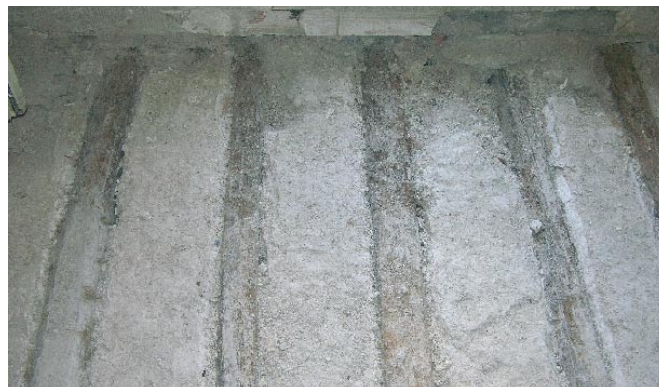
Forjado de madera, de conífera de 130 años de antigüedad, de la misma vivienda madrileña.
