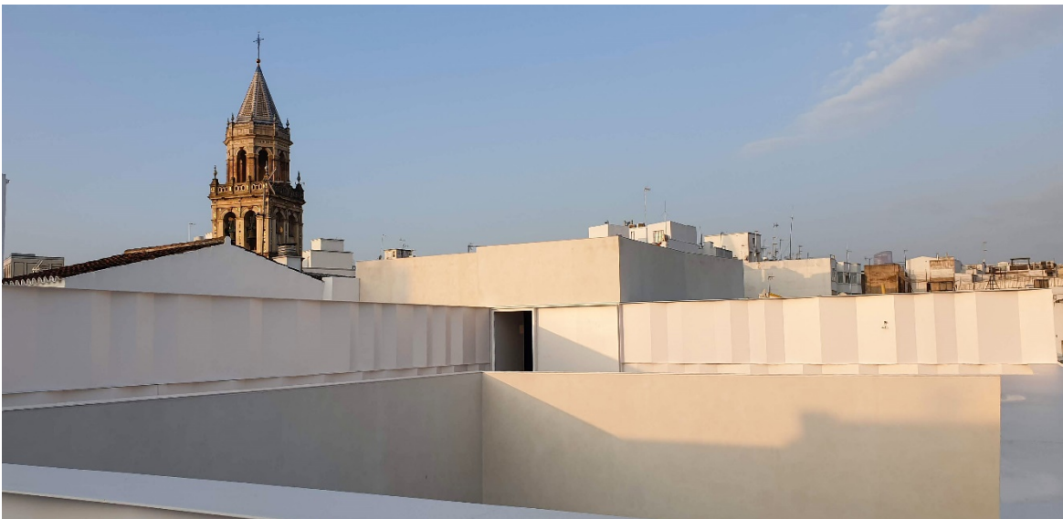
Ampliación del hotel Posada del Lucero, Sevilla
