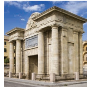
Figura 3. Puerta del puente, Córdoba
