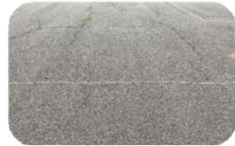
REHABILITACIÓN: REASFALTADO DE SOPORTES CON ESPESORES MÍNIMOS
