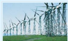
Central de Energia Eólica
