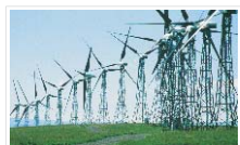
Central de Energia Eólica
