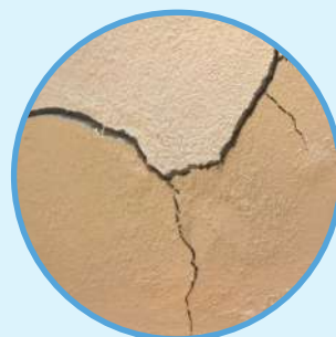
Enfoscado agrietado/hueco
