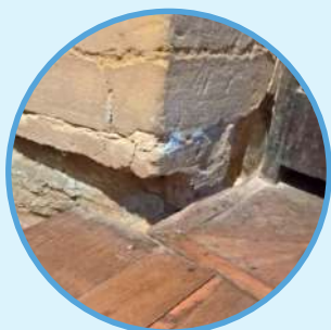
Fábrica resistente destruida
