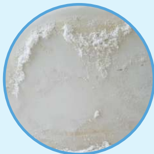
Revestimiento salinizado
