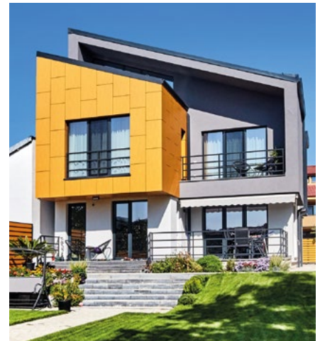
Rehabilitación con Baumit PowerSystem Escuela Infantil Arela (La Coruña) Proyecto: CIESA / Ejecución: Ogmios Proyecto (Foto Javier Alonso, CIESA)
