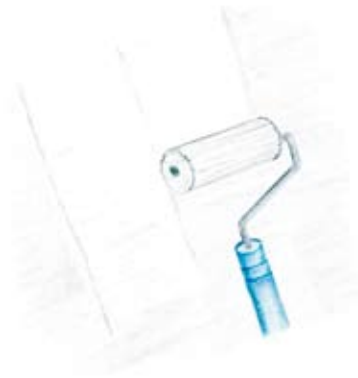
Figura 42 Aplicación de la imprimación mediante rodillo
