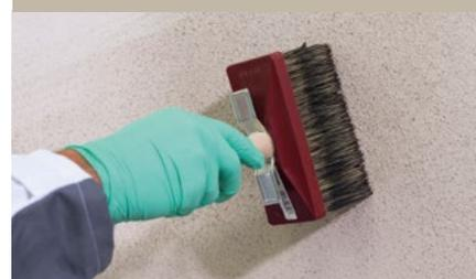
El sustrato no absorbe la pintura por igual en todas las partes. Esto puede producir la pulverización o el desconchado de la pintura.
