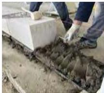
Colocar una capa de mortero de nivelación de no más de 2 cm de espesor y colocar el primer bloque y nivelar con un mazo de goma en la posición horizontal correcta. Compruebe la horizontalidad de los bloques de la primera fila con un nivel. La calidad de la colocación de los bloques de la primera fila depende de la calidad de toda la pared de bloques BAUBLOCK®.
