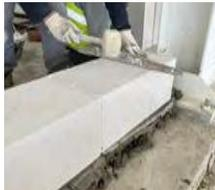
La segunda fila de bloques y todas las subsiguientes deben colocarse sobre Mortero Cola BAUBLOCK®. Es necesario recubrir todas las juntas de mamposterías verticales y horizontales.
