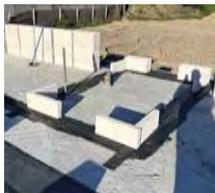
Los cimientos de la vivienda deben tener una capa impermeabilizante necesaria para una correcta elevación posterior del muro.
