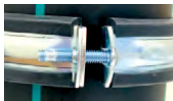
Nivel de apriete de la abrazadera inferior
