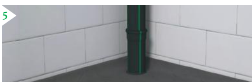
Instale la impermeabilización de planta
