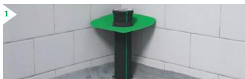
Insertelo en la tubería
