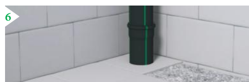
Coloque el relleno y revestimiento del suelo
