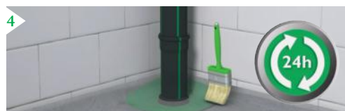
Aplique la segunda capa de imprimación
