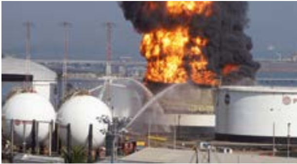
Incendio en refinera por caída de rayo. Puerto Cabello (Venezuela).
