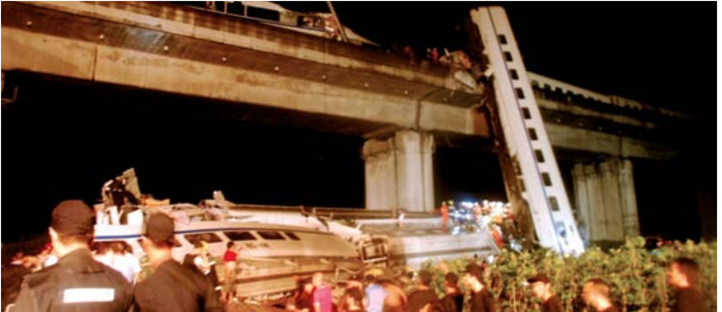
Descarrilamiento de tren por impacto de rayo. Wenzhou (China).
