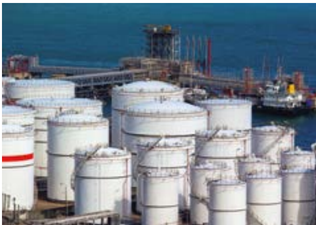
Construcciones y depósitos en los que se manipulen o contengan materiales peligrosos (explosivos, inflamables, tóxicos, etc.)
