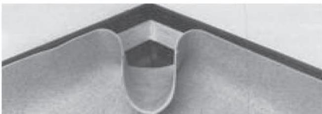
1. Una vez que se haya colocado y pegado adherido la parte principal del suelo, presiónelo hasta la parte interna de la esquina lo máximo posible. Realice un corte desde la base hasta la parte superior siguiendo la forma de la esquina.
