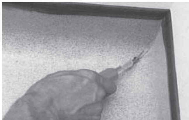
2. Recorte el cordón sobrante con la cuchilla trazadora redonda.
