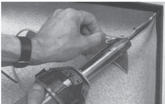
1. Acanale el inglete interno antes de soldarlo.
