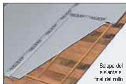
**¡ATENCIÓN!** Es posible colocar el aislante directamente sobre el entarimado de madera sin crear la cámara de aire inferior. No obstante, en este caso la eficacia térmica será menor. Para la aplicación sin cámara de aire inferior se recomienda el TRISO-LAINE max (lana de oveja en contacto con el entarimado de madera). No utilizar nunca aislante de tipo "burbuja" sin cámaras de aire.
