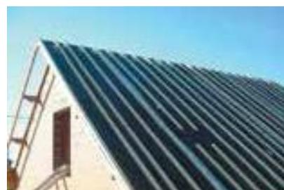
Se aconseja realizar la colocación en vertical en particular si la distancia entre cabios es de 500 mm o 750 mm. En los demás casos: añadir siempre un cabio intermedio o efectuar la colocación horizontalmente.
