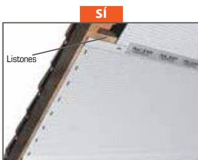
El tramo inferior recubre el tramo superior para asegurar la estanqueidad. El solape se efectúa siempre sobre un listón.
