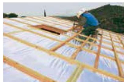
Se aconseja realizar la colocación en vertical en particular si la distancia entre cabio es de 500 mm o 750 mm. En los demás casos: añadir siempre un cabio intermedio o efectuar la colocación en horizontal.
