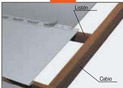
El tramo superior recubre siempre el tramo inferior. El solape se efectúa siempre sobre un listón.
