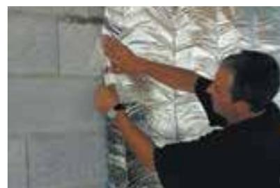
La colocación descrita a continuación puede aplicarse tanto en forjados de hormigón como de madera (en este caso grapar el aislante directamente sobre la estructura de madera).
