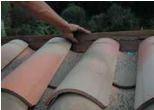
Cómo no es posible amorterar las tejas árabes directamente sobre el aislante ACTIS es necesario prever la colocación de un soporte para las tejas: placa bituminosa o placa de fibrocemento.
