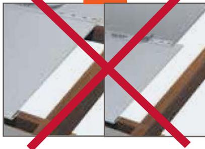
En caso de un alero importante (en la parte baja del faldón o en el contorno del tejado), es posible aislar únicamente hasta 50 mm después del durmiente y colocar en la parte del alero una lámina impermeabilizante para facilitar la evacuación del agua en caso de infiltración accidental. Efectuar los solapes siempre sobre un soporte de madera existente o añadiendo un listón.
